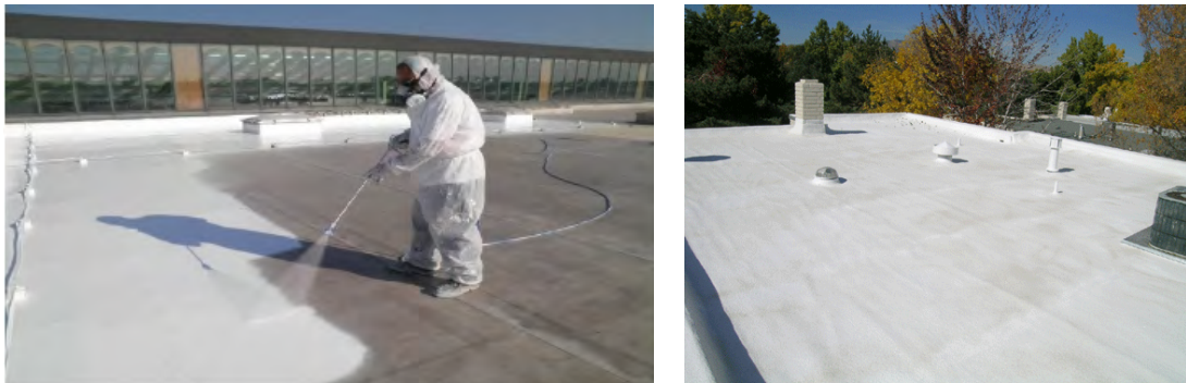
Figura 2 - Aplicação de material fresco em cobertura
