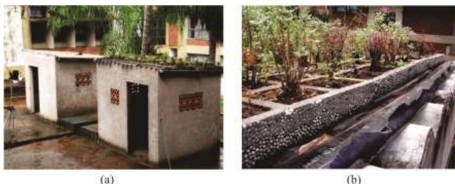
**Figura 14** – (a) Protótipos com telhado instalado e (b) detalhe aproximado das telhas vegetadas
