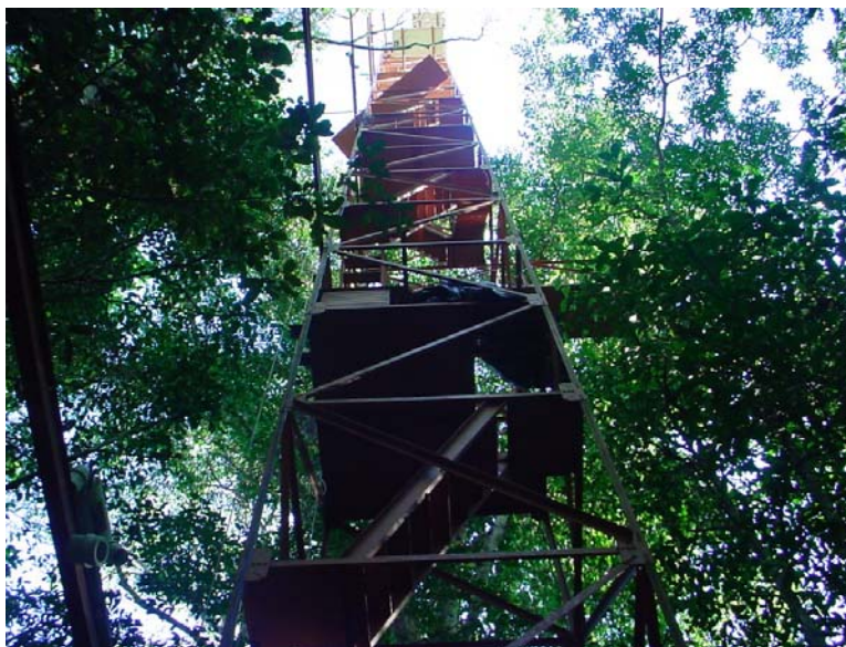
Figura 6 – Foto da torre em Sinop-MT
