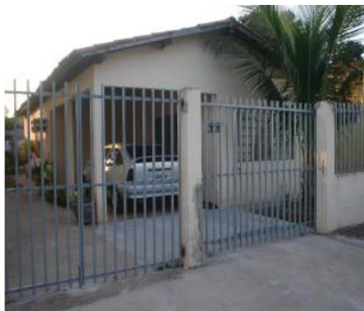
FIGURA 11 – Fachada frontal da residência 02 FONTE: Oliveira (2007)
