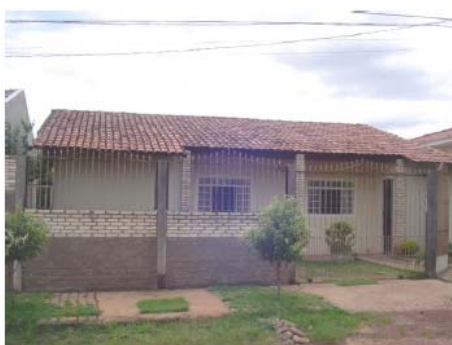
FIGURA 9 – Fachada frontal da residência 01 FONTE: Oliveira (2007)
