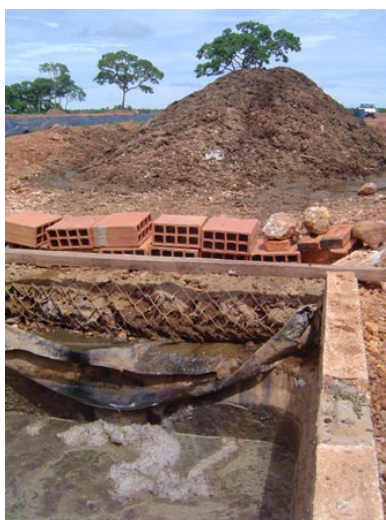
Ilustração 2. Reservatório de captação de chorume localizado na cota inferior das leiras de compostagem.
