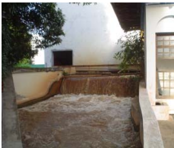
Figura 3 - Chegada da água bruta à estação.
