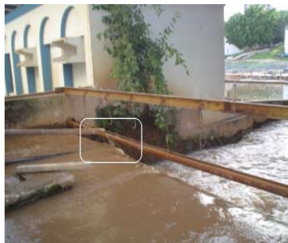
Figura 4 - Ressalto hidráulico, ponto de aplicação do coagulante.
