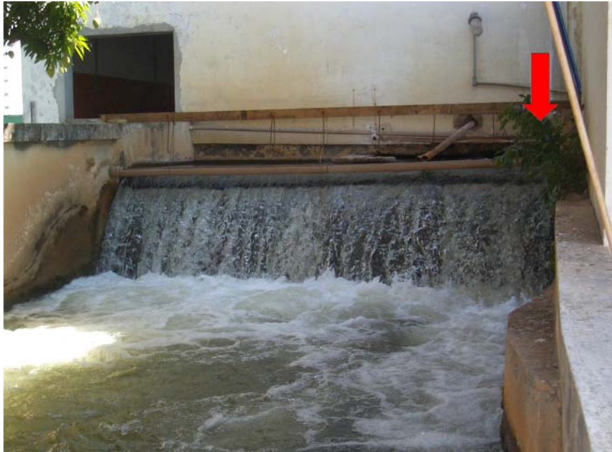
Figura 11 - P1 - Ponto de coleta das amostras na entrada da água bruta na estação.
