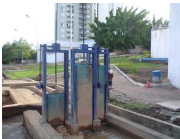
Figura 5 - Comporta de divisão da água coagulada.
