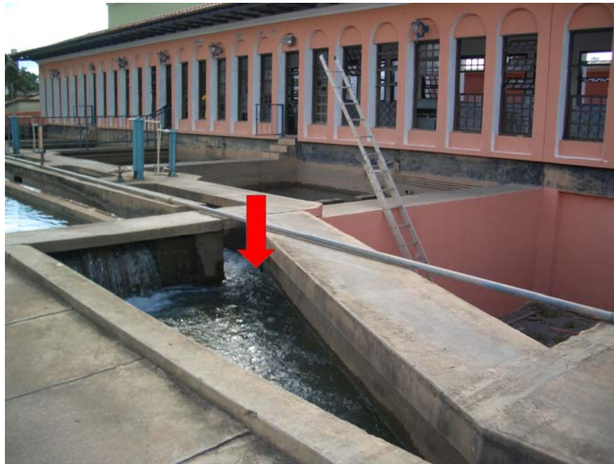
Figura 12 - P2 - Ponto de coleta das amostras no canal de distribuição da água decantada.
