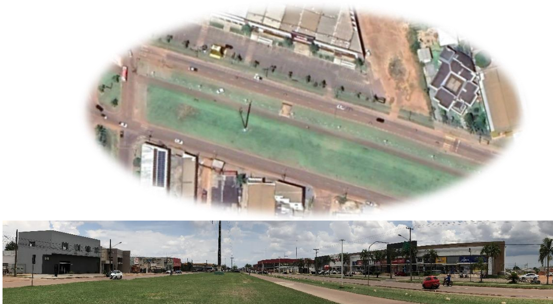
Figura 34 – Imagem panorâmica da avenida André Antônio Maggi.
