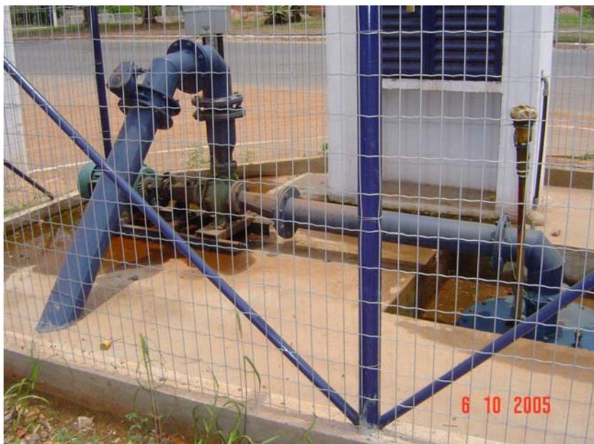
**Figura 10 - Pressurizadora da parte sul do sistema (booster)**
