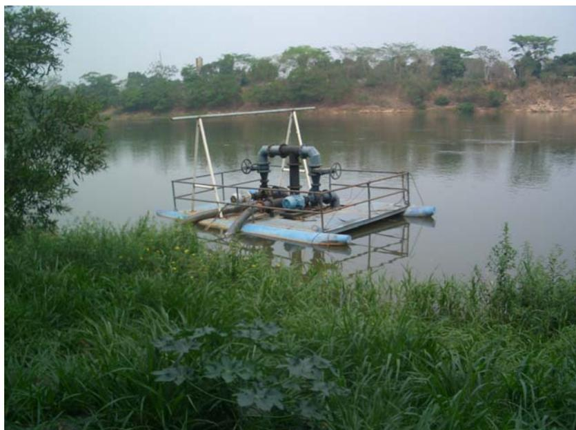
**Figura 11 - Captação de Água Bruta no Rio Cuiabá (Tipo Flutuante)**
