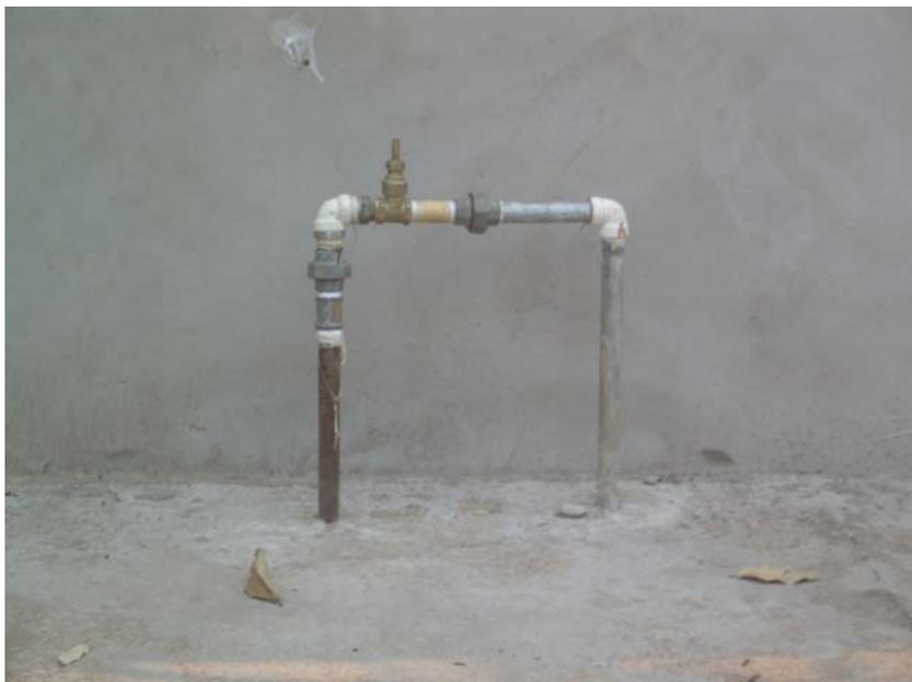
**Figura 50 - Ligação Sem Hidrômetro no Bairro CoopHEMA**
