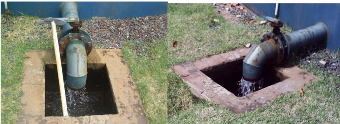
**Figura 14 - Perda de Água no Reservatório**
