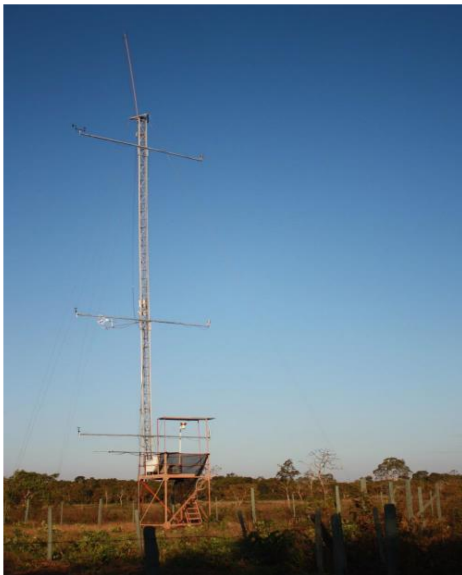
FIGURA 7: Torre micrometeorológica instalada na Fazenda Miranda em uma região com vegetação de pastagem com características de Cerrado
