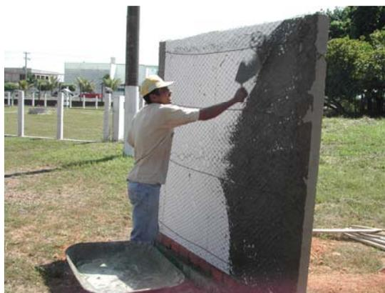
**Figura 21** - Painel composto por EPS após colocação da tela de aço em processo de revestimento.
