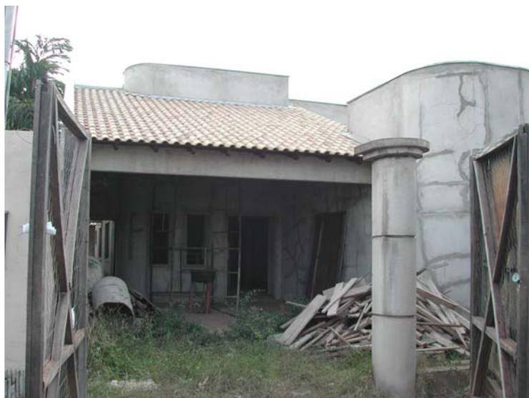
**Figura 14** - Edificação composta por painéis verticais com enchimento com blocos de EPS, edificação “1”.
