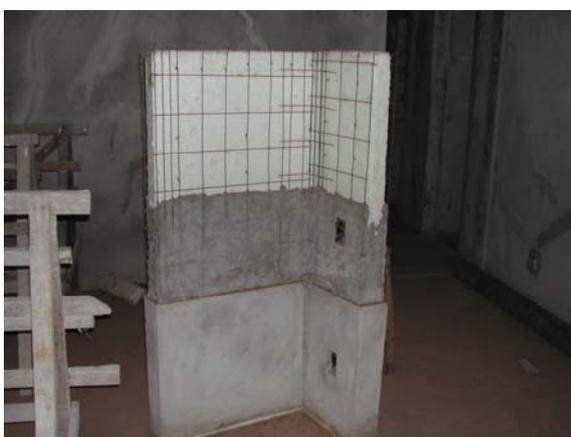
**Figura 10** - Detalhe construtivo de um painel preenchido por EPS.
