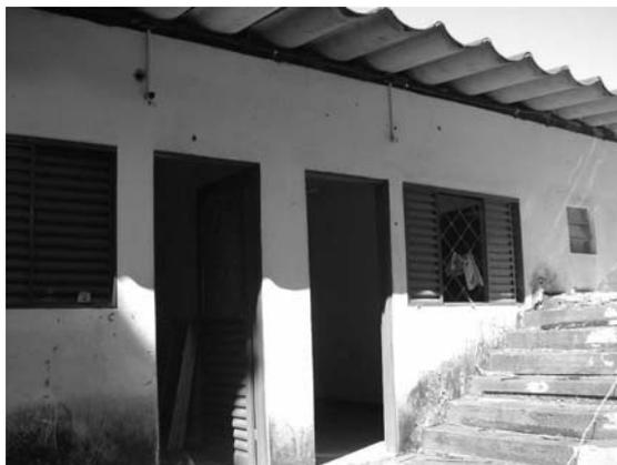
**FIGURA 13** - Edificação de tijolo cerâmico de oito furos
