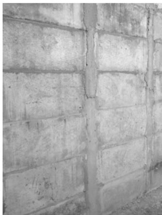
**FIGURA 10** - Painel de placa de argamassa armada com casca de arroz
