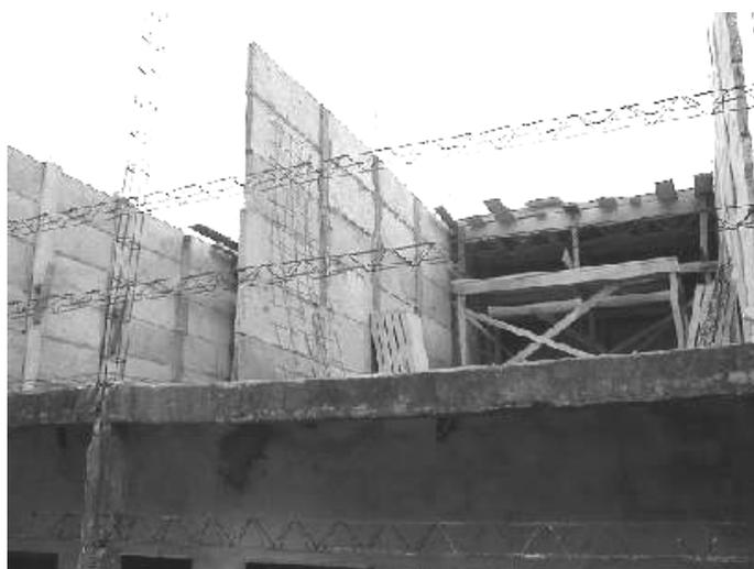
**FIGURA 08** – Sistema construtivo empregando as placas com argamassa especial
