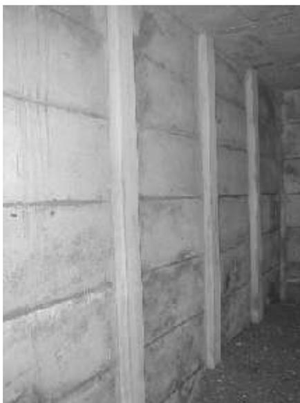
**FIGURA 09** – Painel de fechamento vertical com placas de argamassa especial.
