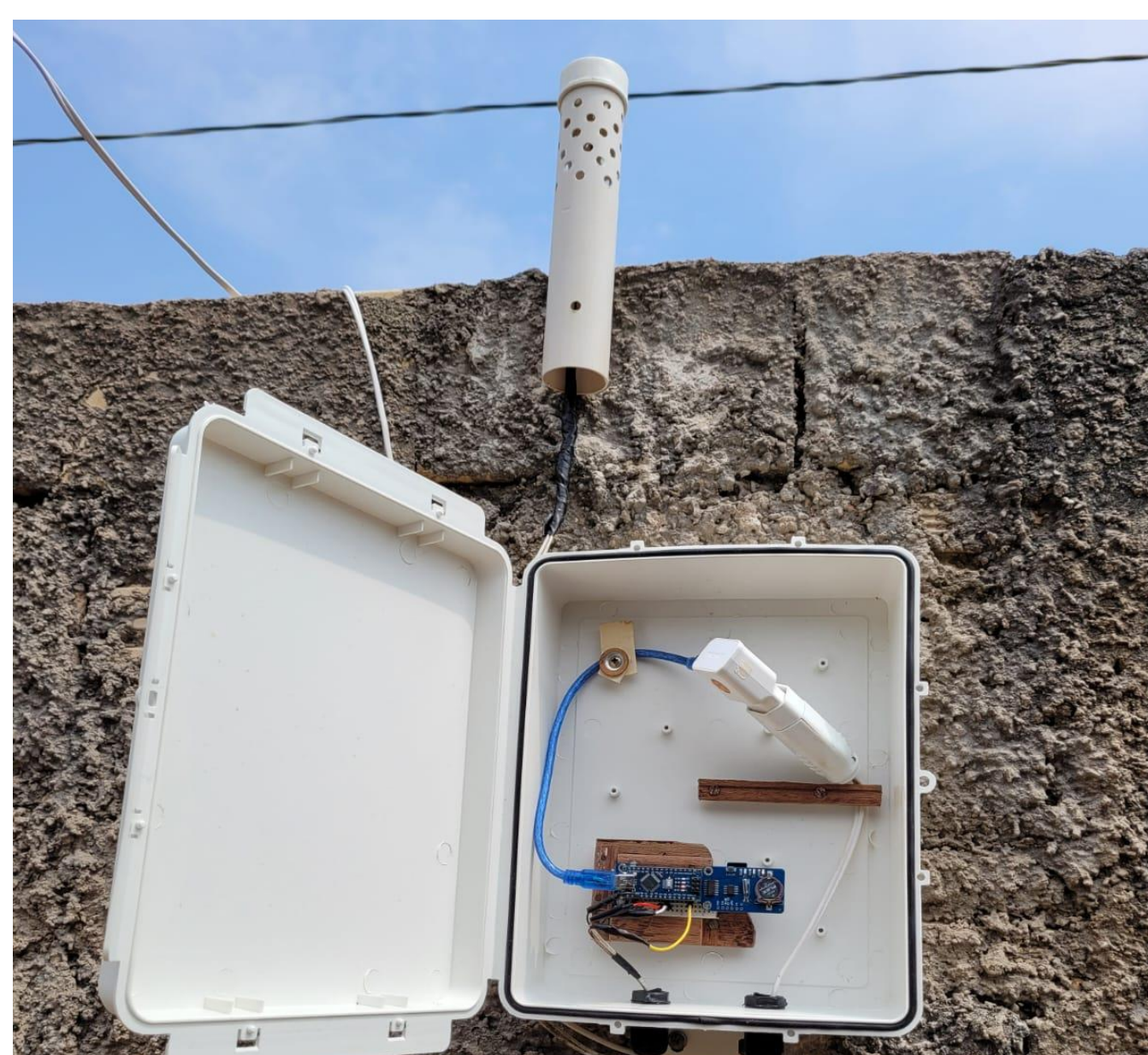
Figura 2 – Estação meteorológica instalada dentro do abrigo.
