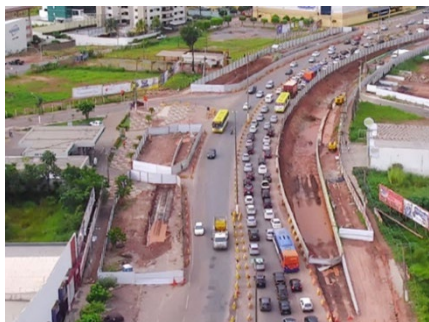
FIGURA 18 - Vista da Avenida Hist. Rubens de Mendonça em 2014, durante as obras de mobilidade.
