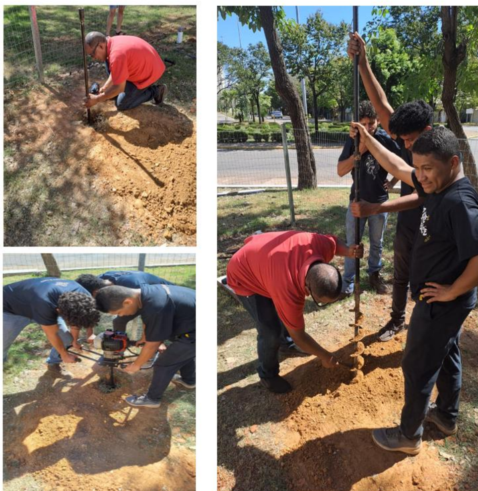
Figura 12. Processo de perfuração para instalação da sonda de temperatura multiponto.
