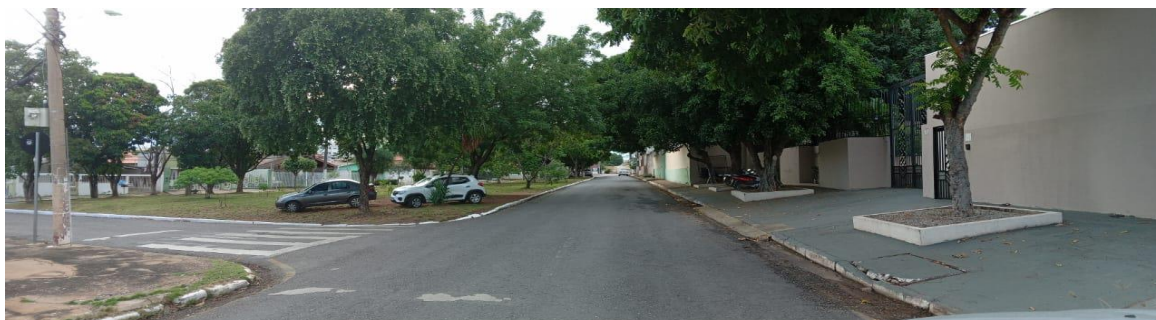
Figura 47 - Imagem panorâmica do ponto 12-Rua Cel. João Lourenço de Figueiredo
