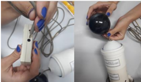
Figura 57 - Instalação do sensor termo-higrômetro data logger.
