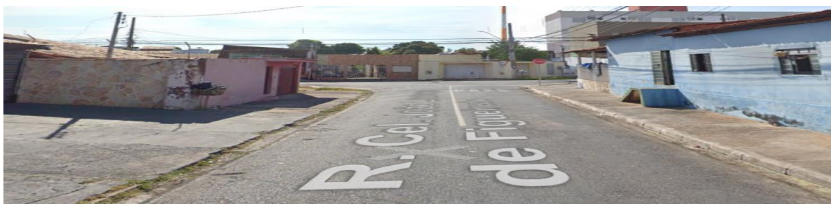
Figura 49 - Imagem panorâmica do ponto 13-Rua Cel. João Lourenço de Figueiredo
