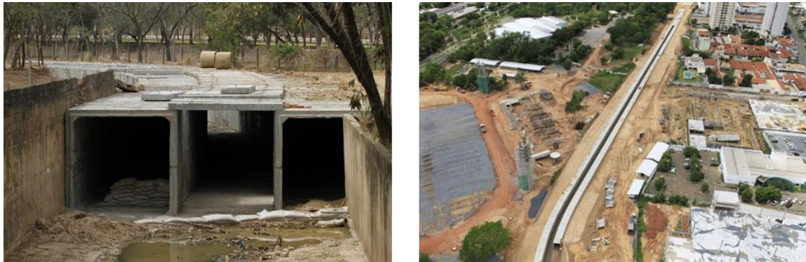
Figura 4 - Obras de tamponamento do córrego do Barbados
