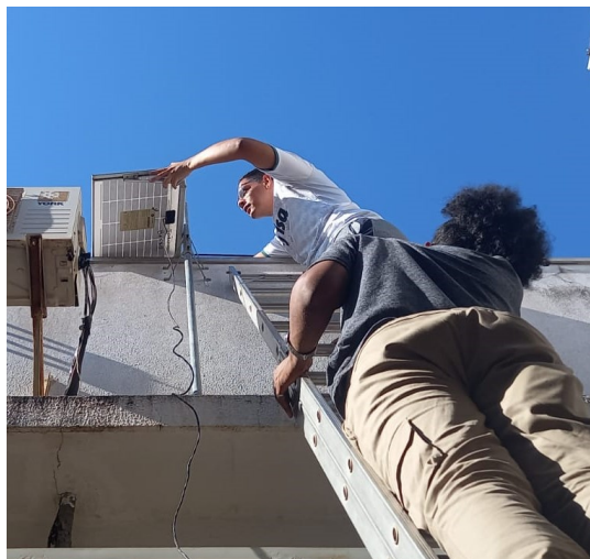
Figura 3.6: Instalação da Placa Solar. Fonte: Arquivo pessoal da Autora.
