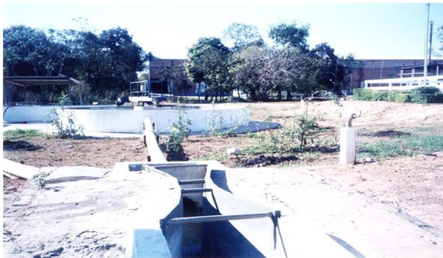
Figura 13: Liberação final dos líquidos resultantes do processo de tratamento.
