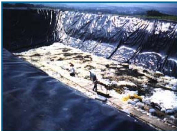
Figura 16. Execução de impermeabilização em uma célula tipo para disposição de resíduos industriais perigosos.
