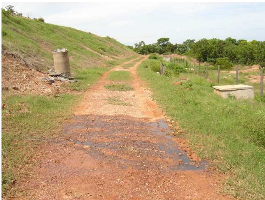
**FIGURA 39** – Fuga lateral de chorume na parte impermeabilizada do aterro - 21/12/2005
